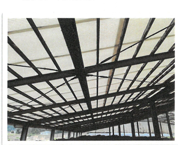
補修後 堆肥舎屋根
