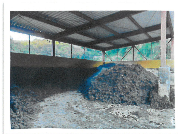
補修後 堆肥舎 壁
