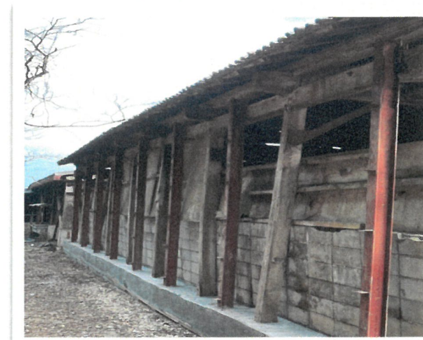
補修後 堆肥舎 柱
