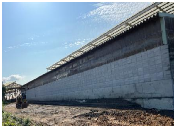
補修後 堆肥舎 壁
