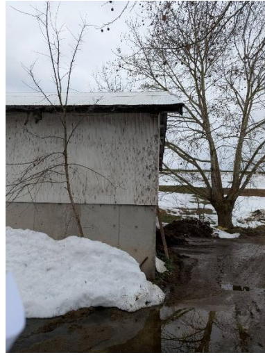
補修後 堆肥舎 屋根
