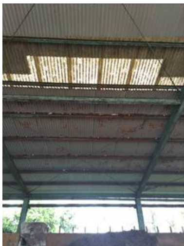
補修前 堆肥舎 屋根
