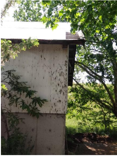
補修前 堆肥舎 屋根
