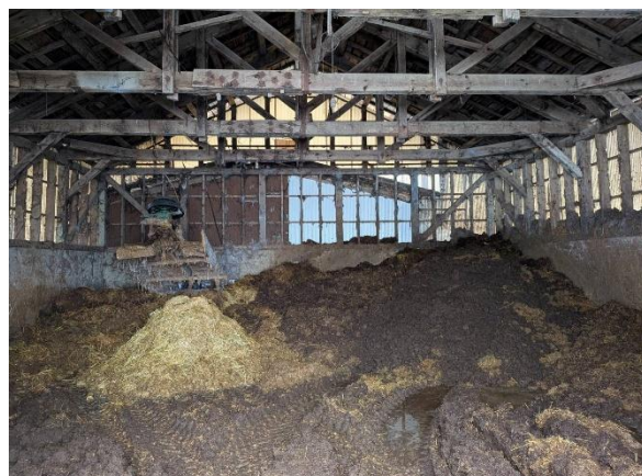
補修後 堆肥舎 壁
