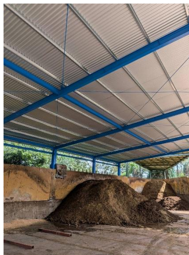
補修後 堆肥舎 屋根
